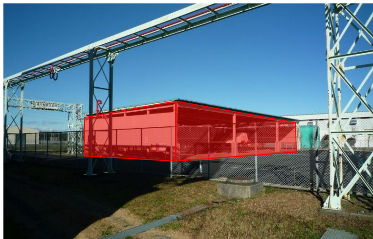
水素貯蔵所(障壁の設置イメージ)
